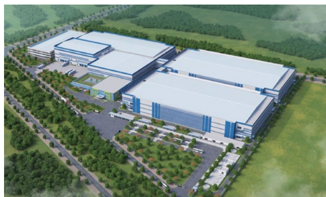
Dự án: Nhà máy ICT Nghên An
