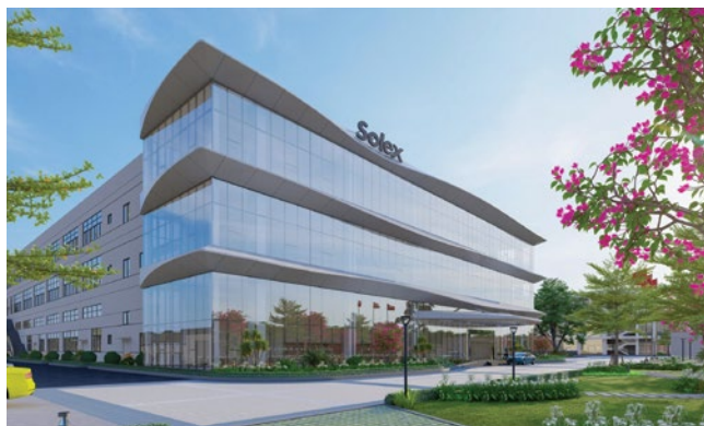
Dự án: Nhà máy Solex High Tech Industries
