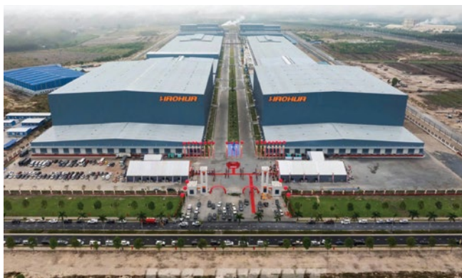
Dự án: Nhà máy sản xuất lớp ô tô HAOHUA
